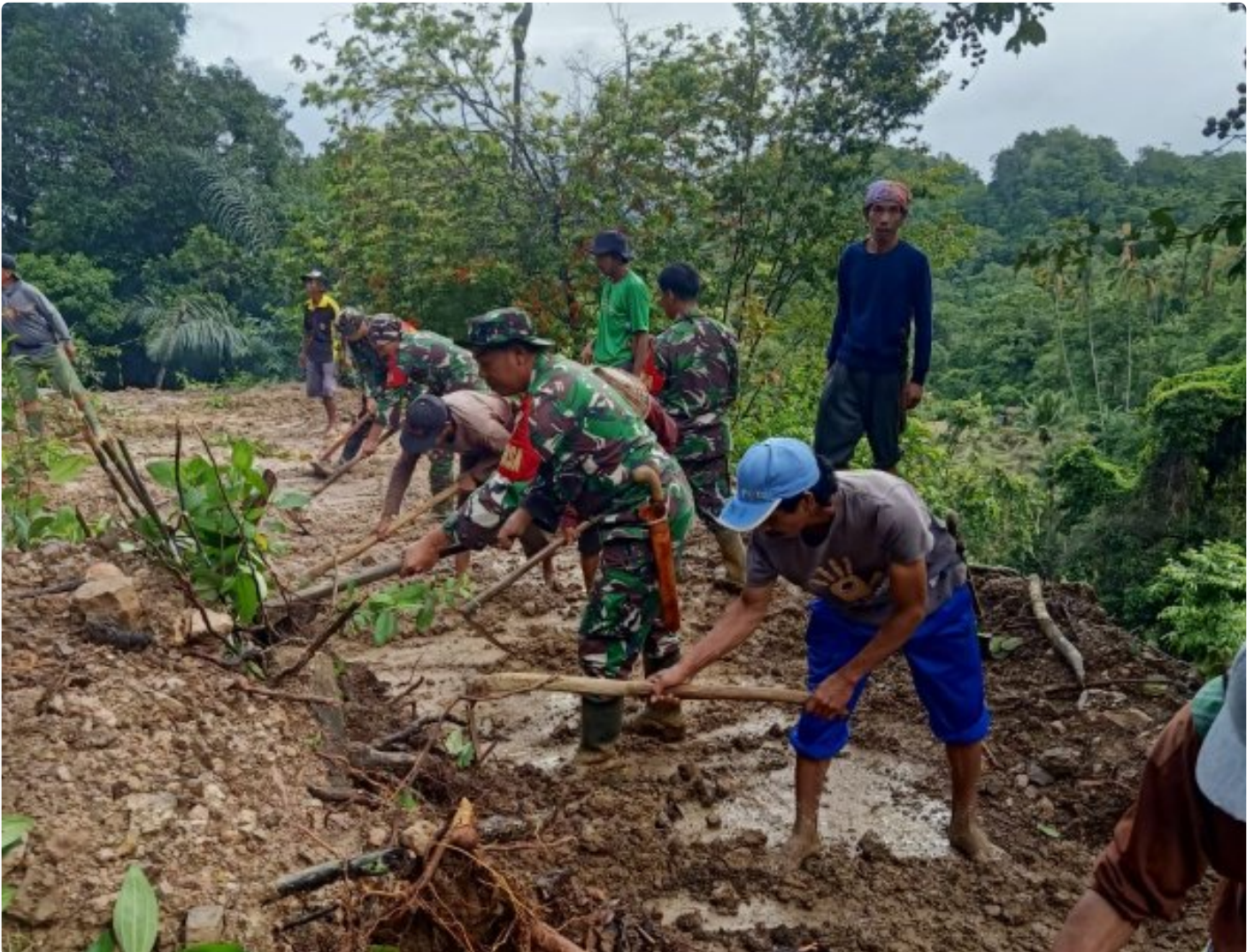
Koramil 1421-01/Balocci Tanggap Bersihkan Jalan Pasca Bencana Tanah Longsor.
